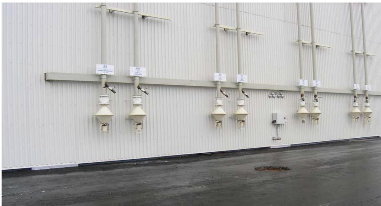
Основные исходные компоненты из автоцистерн загружаются в силосы с помощью сжатого воздуха. В общем случае сжатый воздух поступает от штатного компрессора автоцистерны. С целью сокращения времени загрузки песка автоцистерна может дополнительно подключаться к установленному стационарно компрессору, давление 3.0 атм., 7 м./мин.
